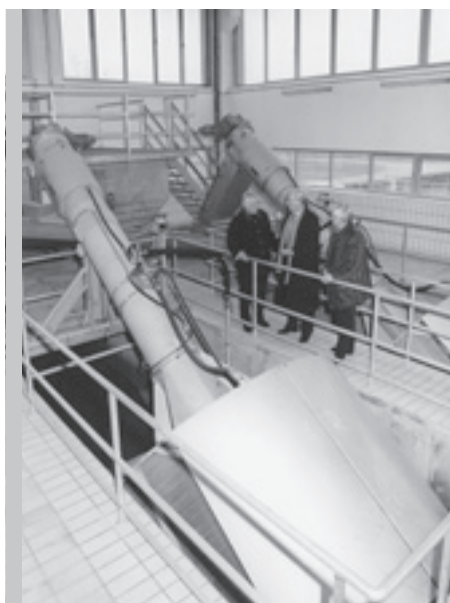
Besichtigung eines neuen Korbrechens im Bereich der Kläranlage.
