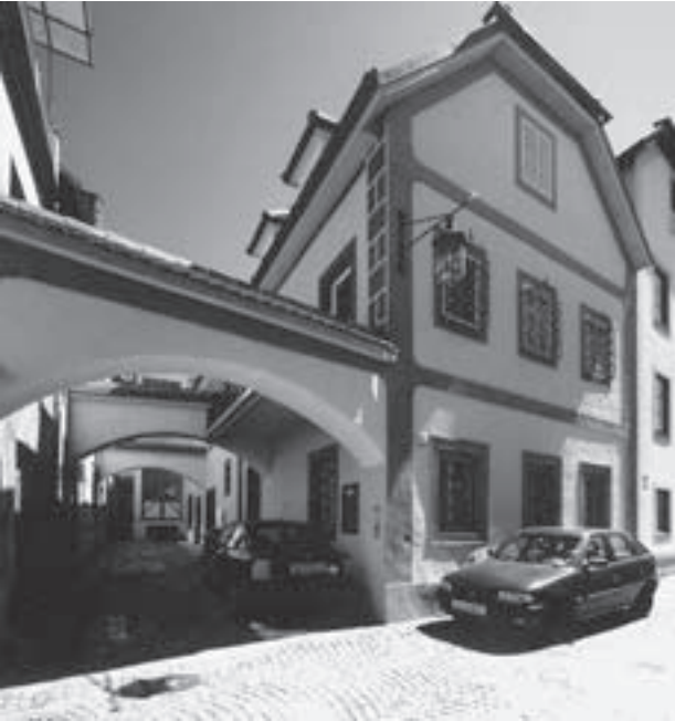
KOLLERGASSE 5: Das kleine, im Kern aus dem 16. Jahrhundert stammende ehemalige Handwerkerhaus beinhaltet auch einen kleinen Hof. Bei der Gesamtanierung ist im Hofbereich die ursprüngliche Fassadenfassung aus der Renaissancezeit freigelegt und restauriert worden. Die Fassade zur Kollergasse stammt aus einer späteren Zeit, ist aber in der Farbgebung dem Innenhof angepasst worden. Im Erdgeschoß hat man die fehlenden Fenstergitter ergänzt, im ersten Obergeschoß sind historische Schmiedeeisenkörbe angebracht worden. Die Kastenfenster entsprechen ebenfalls dem historischen Vorbild.
