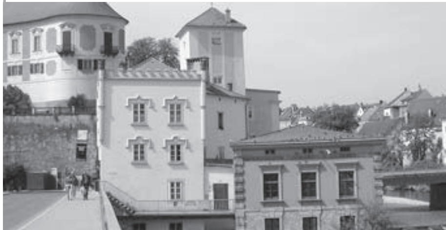
Das Vereinsheim der Steyrer Naturfreunde im Haus Zwischenbrücken 2 (Bildmitte) musste nach der Hochwasserkatastrophe umfangreich saniert werden. Der Abschluss der Arbeiten wird am 26. September gefeiert.
