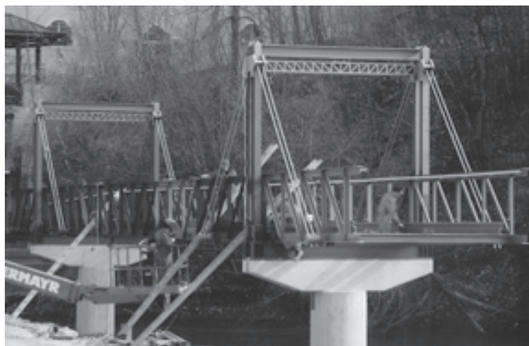
Eine der Schutz-Maßnahmen, um künftige Hochwasser-Schäden so gut wie möglich zu verringern: Der bereits neu errichtete Museumssteg ist im Bereich der Pfeiler erhöht worden, die Standfestigkeit des gesamten Bauwerks hat man wesentlich gesteigert. Im Bild: der Brücken-Neubau in der Schlussphase (April 2003).
