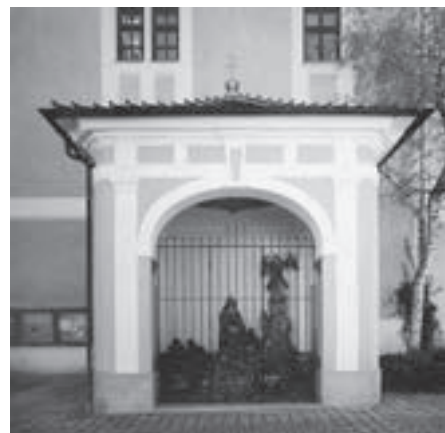
Eine der beiden Kapellen vor der Marienkirche: Das neue Schmiedeeisengitter gewährt die notwendige Sicht auf die Figuren und schützt vor Vandalismus.
