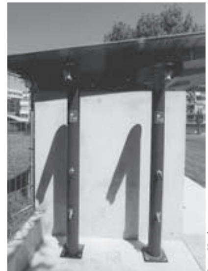
Ebenfalls neu im historischen Arbeiterbad: Solarduschen.
