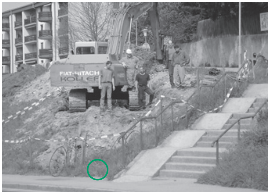
Hier im Bereich der Kegelprielstiege endete die Bohrung (markiert) in drei Metern Tiefe - nur wenige Zentimeter neben der geplanten Stelle.
