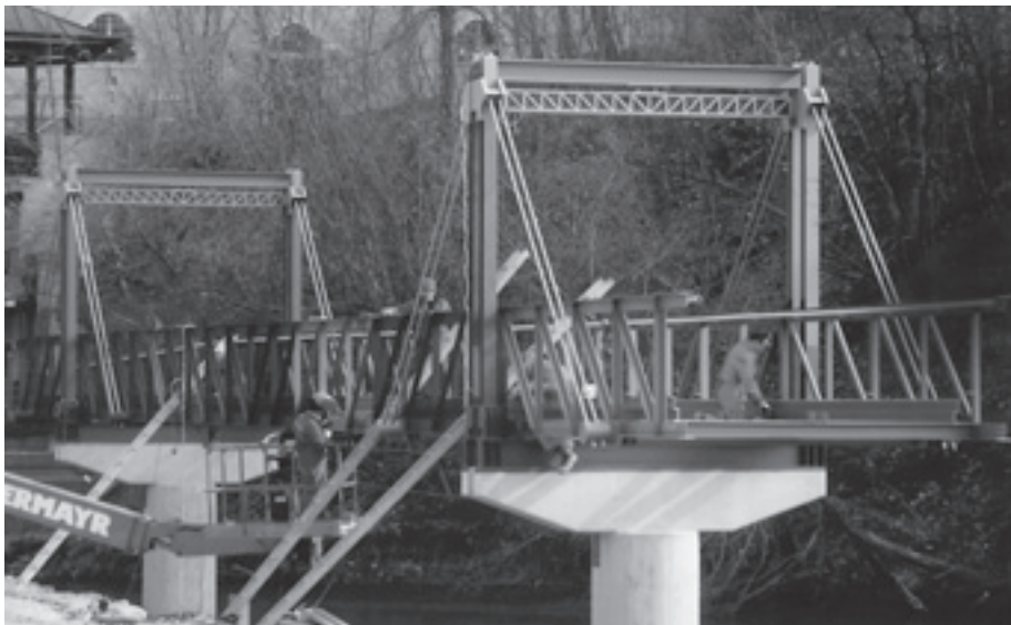
Ein Tragwerks-Teil wird auf den Flusspfeiler beim linken Ufer (auf der Seite des Museums) gehoben.
