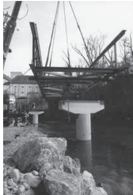
Ein Tragwerks-Teil wird auf den Flusspfeiler beim linken Ufer (auf der Seite des Museums) gehoben.
