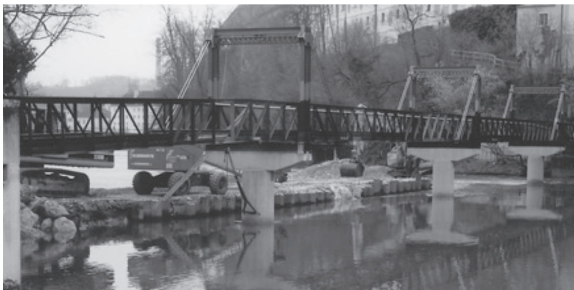
Das Tragwerk ist fertig gestellt. Im Hintergrund sieht man, wie der angeschüttete Arbeitsdamm mit dem Bagger bereits rückgebaut wird.
