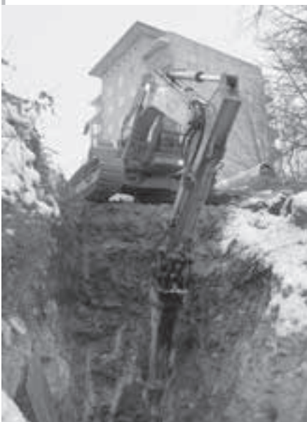
Die alten Kanalrohre im Steilhang unterhalb des Hochhauses Glöckelstraße mussten unter schwierigsten Arbeitsbedingungen ausgetauscht werden.
