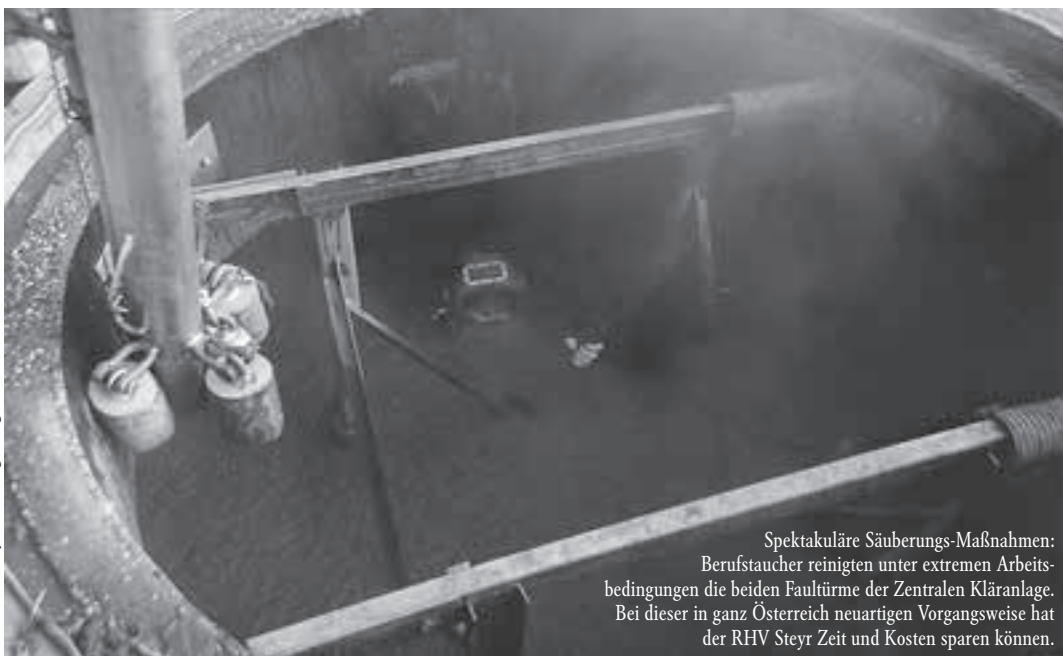
Einer der Taucher, ausgerüstet mit Trockentauchanzug, vor dem Einstieg in den mit flüssigem Schlamm gefüllten Faulturm.
