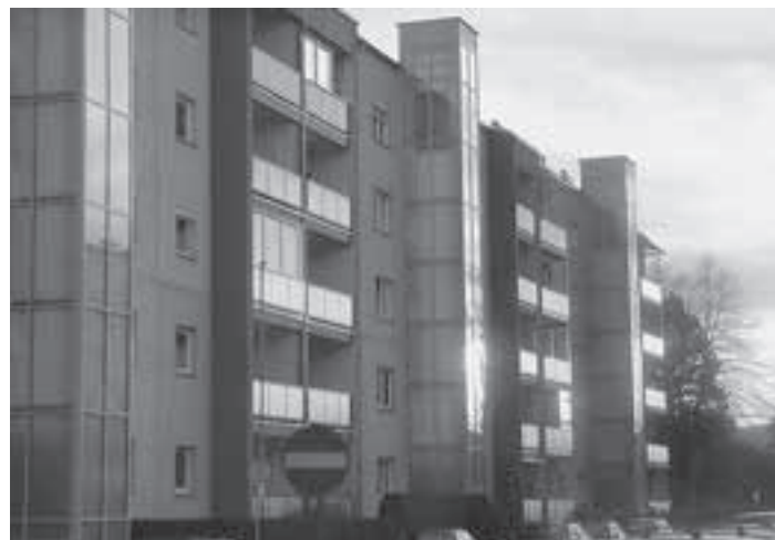
Die GWG der Stadt Steyr hat mit dem nachträglichen Einbau von Personenliften in den Stadtteilen Ennsleite und Tabor begonnen. Die ersten Aufzugsanlagen (hier im Bild an der Roseggerstraße) sind seit kurzem fertig gestellt und bereits in Betrieb.
