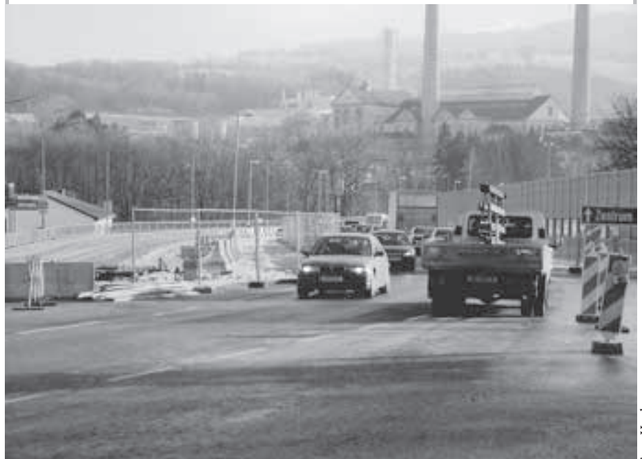
Die Straßenbau-Abteilung der Oberösterreichischen Landesregierung wird in Kürze mit dem Abriss der alten Rederbrücke (auf dem Foto links) beginnen. Dann wird der neue Kreisverkehr errichtet, sodass dieser Bereich von allen Verkehrsteilnehmern bald wieder ungehindert benützt werden kann.
